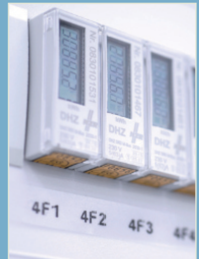
Zertifizierte Strommessgeräte je Kunde und Schaltkreis zur Überwachung und Abrechnung.
