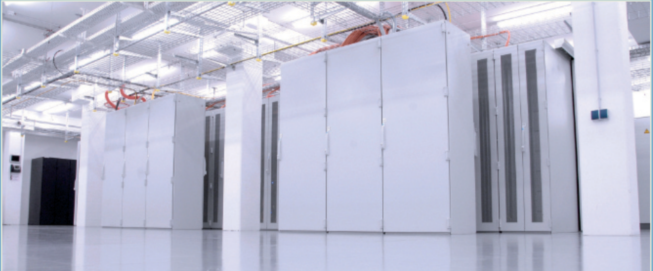
Belüftete Kundenracks (Rückseite) mit oben liegenden getrennten Faser- und Kupferkabeltrassen. Zentrale MMR/ODF-Racks (Vorderseite).
