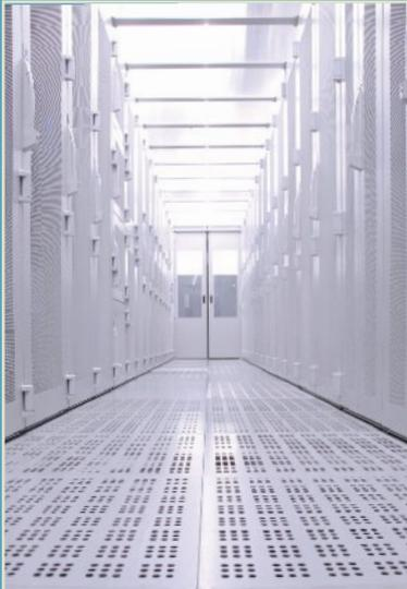
Die Kaltgangeinhausung ist eine hochmoderne Lösung für Energieeffizienz und Kaltluftverteilung.
